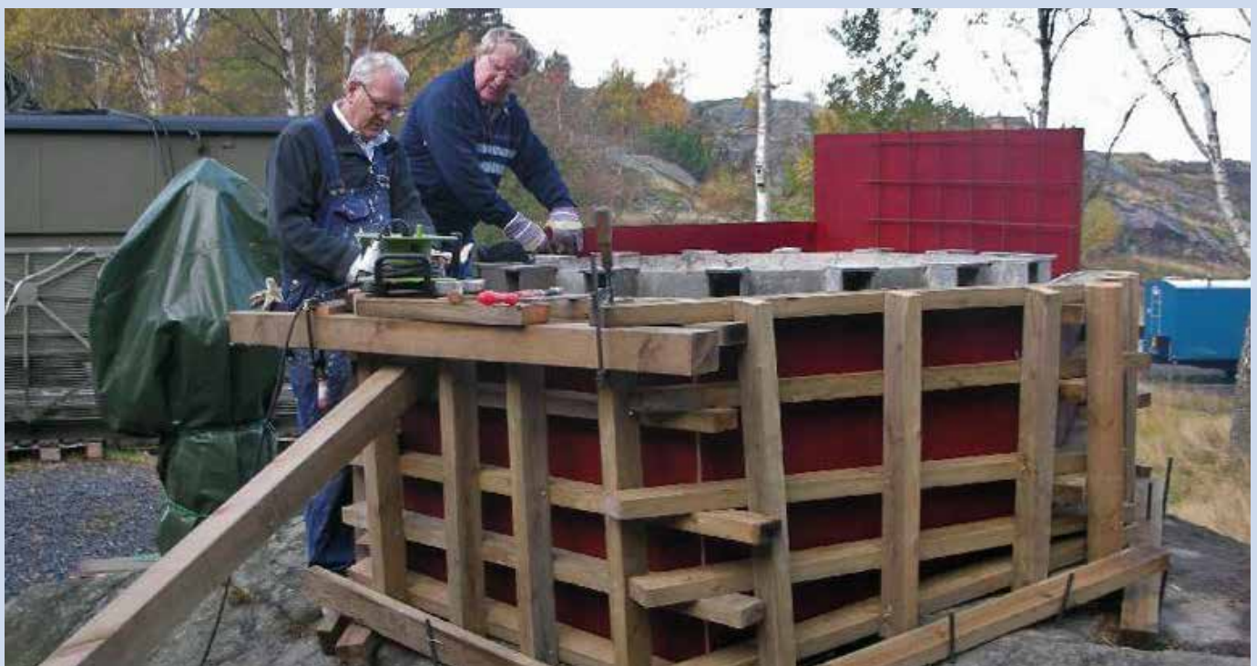
Ebbe o Barth vid gjutning av antennfundamentet
