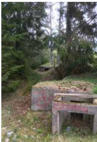
SK16 vörn vid Kranhults bro
